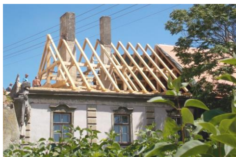
Fara v Dyjácovicích – II. etapa opravy střechy vč. výměny krovu (693.000 Kč)
