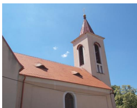
Kostel Zasnoubení Panny Marie v Mackovicích – II. etapa opravy střechy (274.000 Kč)
