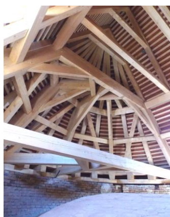
Kostel Nanebevzetí Panny Marie v Hevlíně – III. etapa opravy střechy kostela (319.000 Kč)
