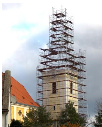
Kostel Nanebevzetí P. Marie v Tasovicích – I. etapa opravy střechy věže vč. výměny krokové konstrukce (1.462.000 Kč)
