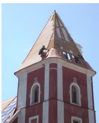
Kostel sv. Jiří v Lubnici – II. etapa opravy střechy a krovu (384.000 Kč)
