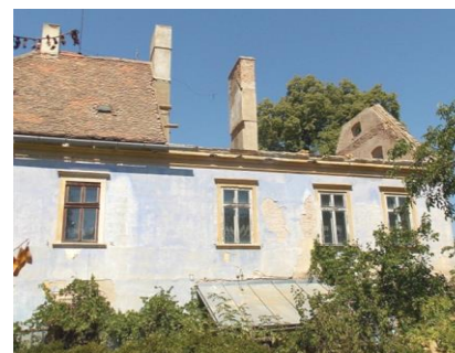
Fara Božice – I. etapa opravy střechy a krovu (867.000 Kč)
