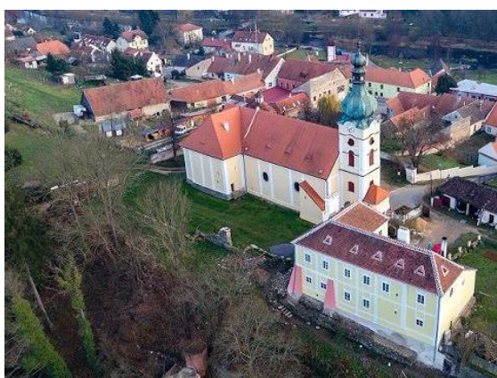
Fara ve Vranově n. Dyjí – oprava střechy a fasády
